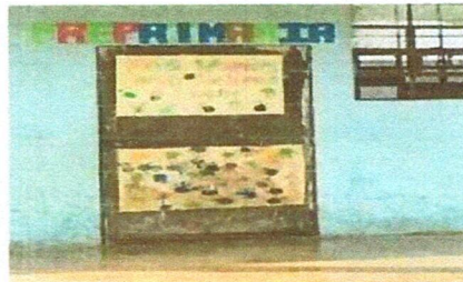
Remozamiento de puertas, lijado y cambio de marcos por daños de oxidacion y pintura anticorrosiva de puerta
