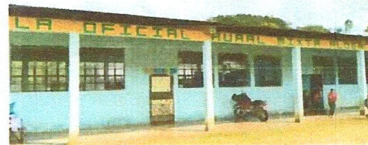
Pintura de interior y exterior por deterioro de la misma
