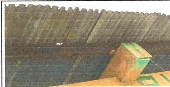
Lijado y pintado de costaneras por deterioro y oxidacion visible
